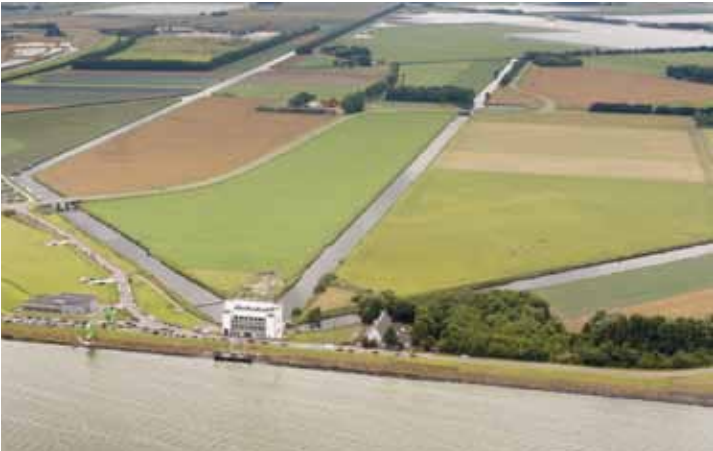
Het monumentale gemaal Lely bij Medemblik aan het IJsselmeer. Het IJsselmeerwater spoelt de sloten door om verzilting te voorkomen.
