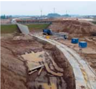
Voordat de L-wand wordt aangebracht (achter op de foto) is het kwelscherm nog zichtbaar.
