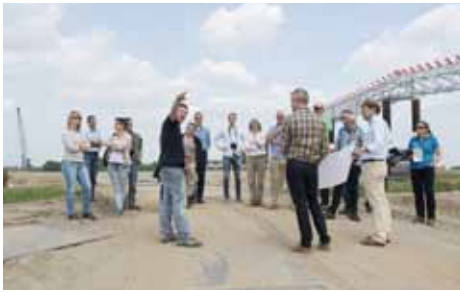
Bij de zandinstallatie.
